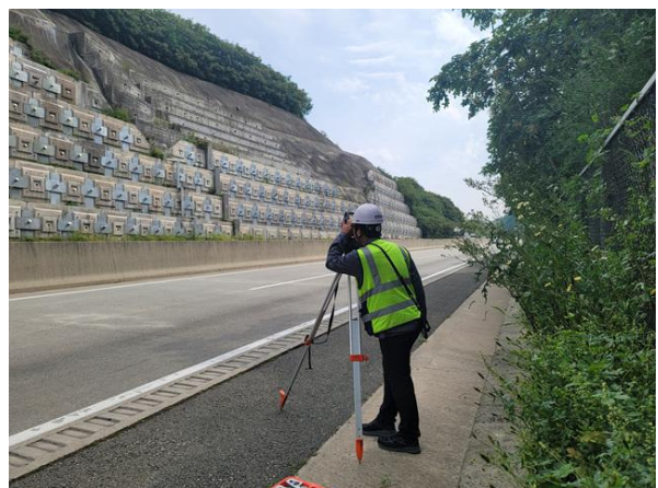
광파기를 이용한 경사도 측정
