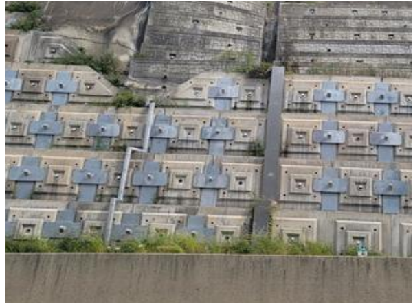
배수관, 배수로 전경
